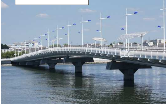
Pont des Indes Lorient 2007 PONT A POUTRES pont-route ; béton.
