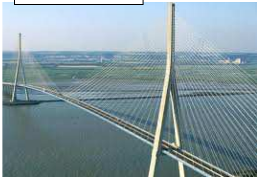
Pont de Normandie Le Havre 1995 PONT A HAUBANS pont-autoroute.
