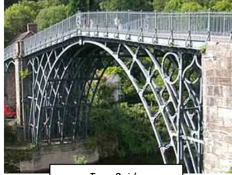
Iron Bridge Angleterre 1779 PONT EN ARC pont-route ; fonte.
