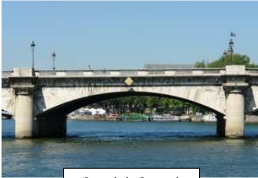
Pont de la Concorde Paris 1791 PONT EN ARC pont-route ; pierre.
