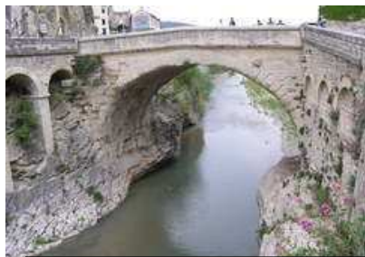
Pont romain Vaison-la-Romaine (Vaucluse) 1 er siècle PONT EN ARC pont-route ; pierre.
