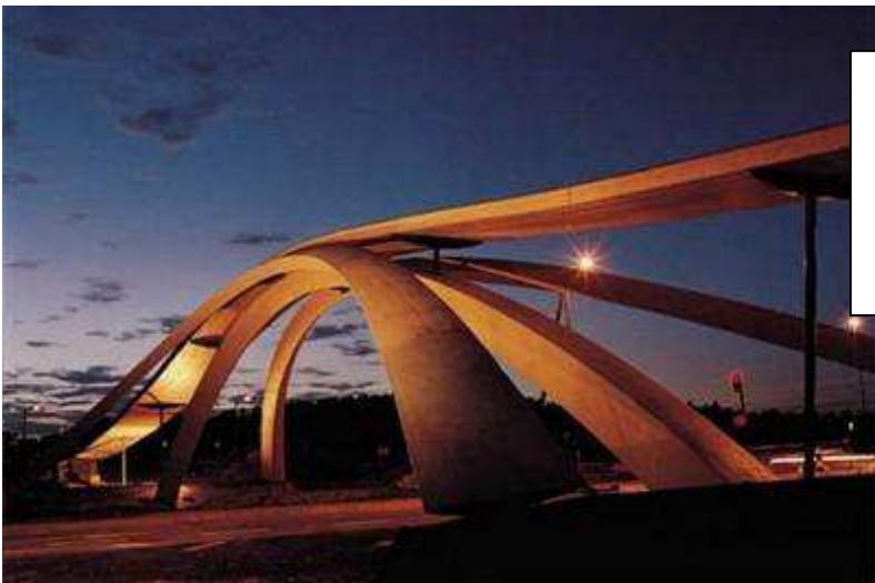
Pont Léonard de Vinci As (Norvège) 2001 pont-piétons réalisé en bois d'après un projet dessiné en 1502 par Léonard DE VINCI.
