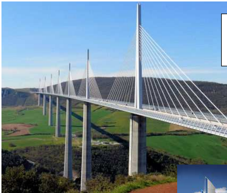
Viaduc de Millau Aveyron 2004 pont-autoroute pont routier le plus haut du monde 343 m.
